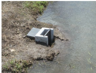
流量調整排水ます設置
