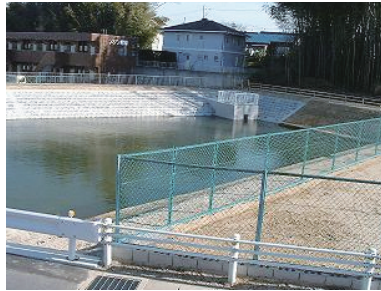
二ツ池の洪水調整機能設置
